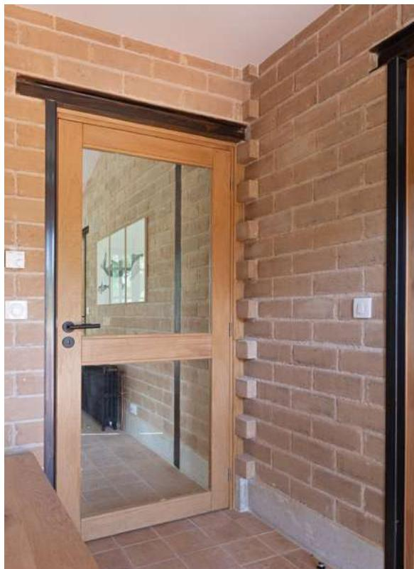
L'épaisseur de 20 cm des cloisons en terre crue a obligé le maçon à réaliser des **encadrements de portes en acier brut** revêtu d'une simple couche de Rustol pour la protection et l'esthétique. Porte vitrée en bois massif.
